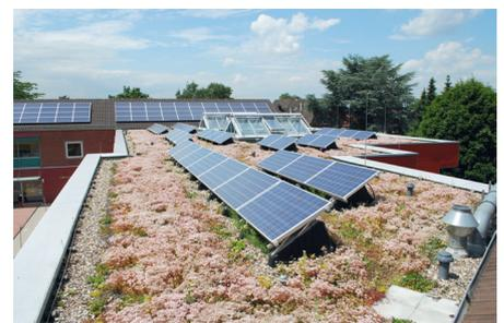
(9) SolarGrünDach. Leistungssteigerung der Photovoltaikanlage durch die Kühlleistung der Dachbegrünung
